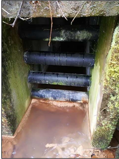
a) Exhaure de la galerie du Repaire
