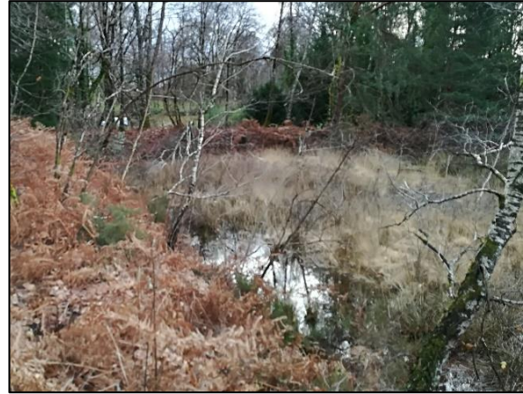
d) Bassin de décantation n°7 contenu par une digue
