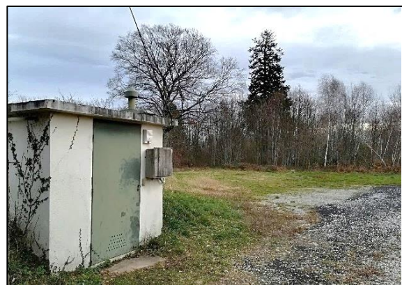
b) Château d'eau et emplacement de l'ancien bassin incendie (comblé)
